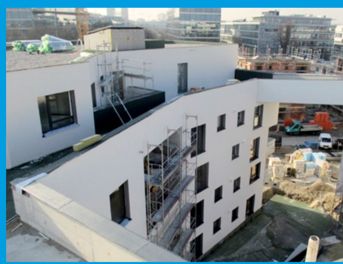
07 Rohbau mit charakteristischen Brücken
